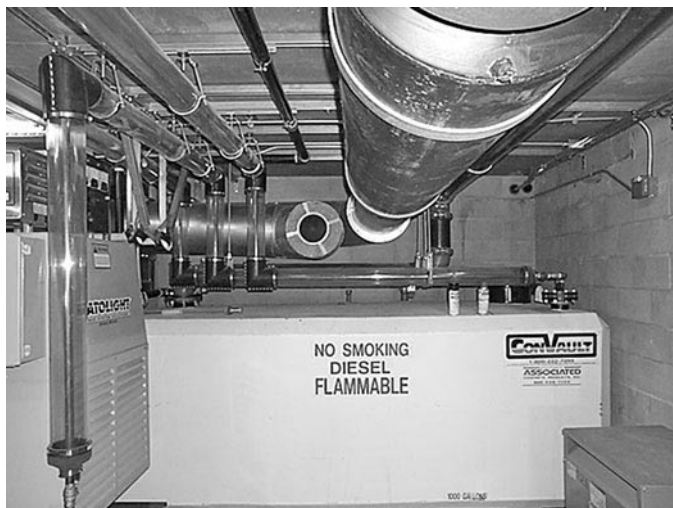
Рис. 6.2. Бак емкостью 1000 галлонов для заправки генераторов в корпорации GNAC
