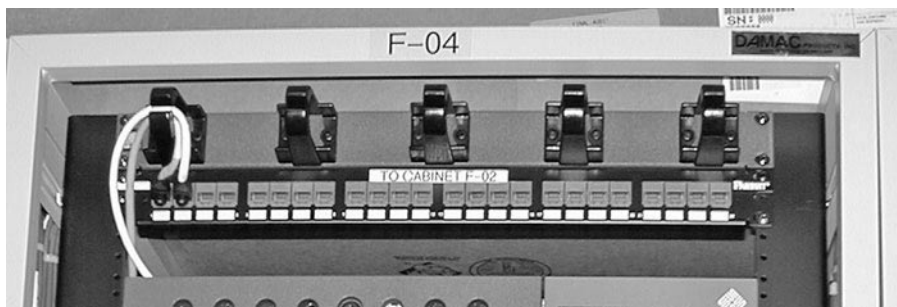
Рис. 6.9. На верхней части стоек в компании Synopsys наклеены ярлыки и установлены патч-панели, где указана стойка, в которой они находятся
